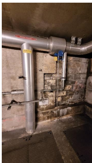
Figure 15 - Arrivée Eau de ville dans tube Nord à modifier
